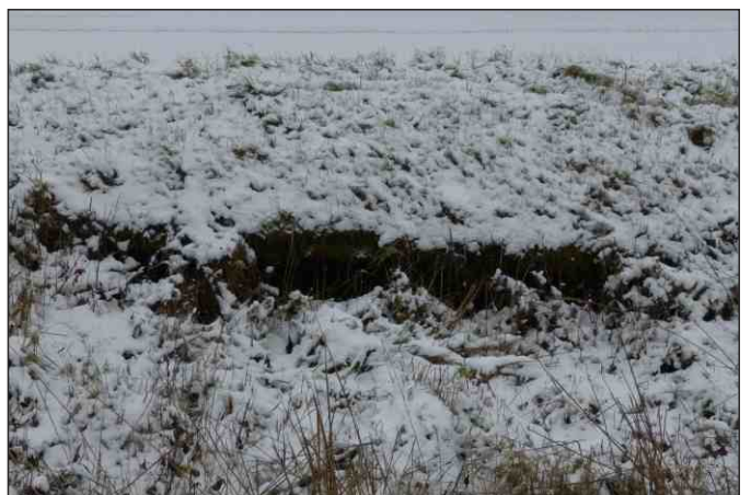
Propustek 2c odbočka k chatám - staničení 0,021 - pohled zleva
