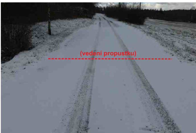
Propustek 2c odbočka k chatám - staničení 0,021 - celkový pohled
