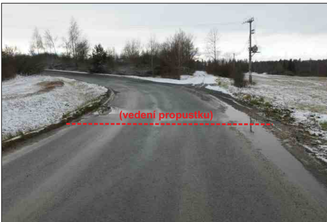
Propustek 2c - staničení 1,156 - celkový pohled
