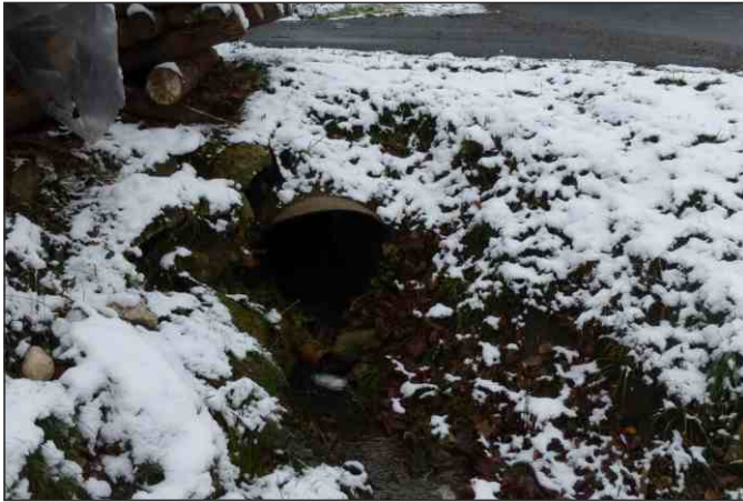
Propustek 11c - staničení 0,004 - pohled zleva
