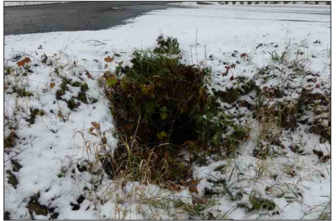
Propustek 1c - staničení 0,000 - pohled zleva
