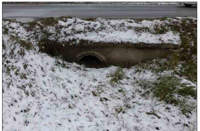
Propustek 2c - staničení 1,156 - pohled zleva
