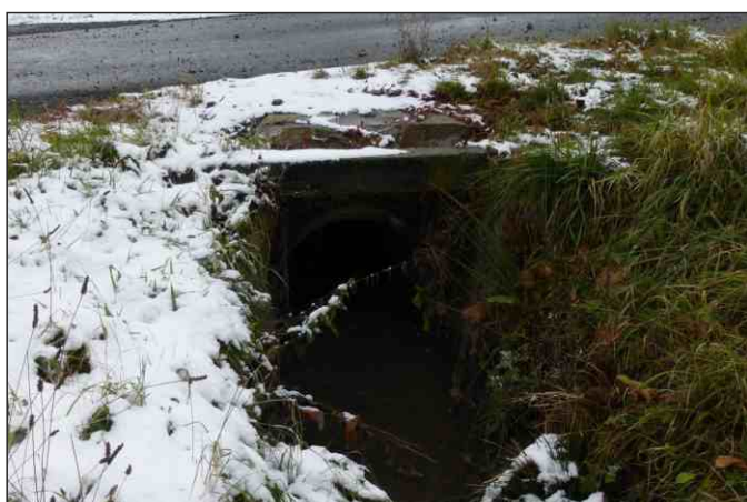
Propustek 8c - staničení 0,005 - pohled zleva
