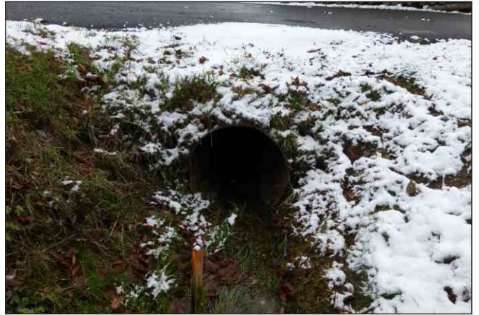
Propustek 11c - staničení 0,004 - pohled zprava
