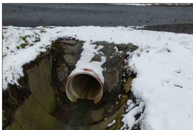
Propustek 8c - staničení 0,005 - pohled zprava
