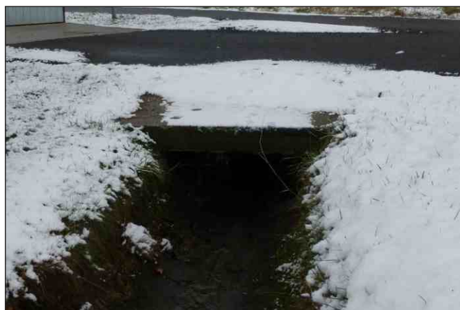
Propustek 7c - staničení 0,014 - pohled zleva
