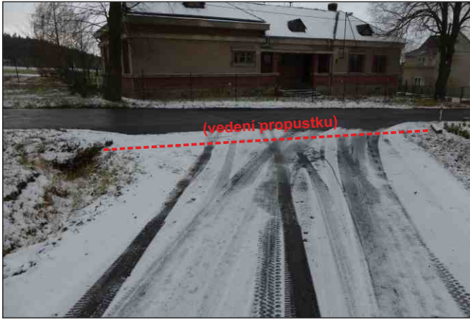
Propustek 1c - staničení 0,000 - celkový pohled
