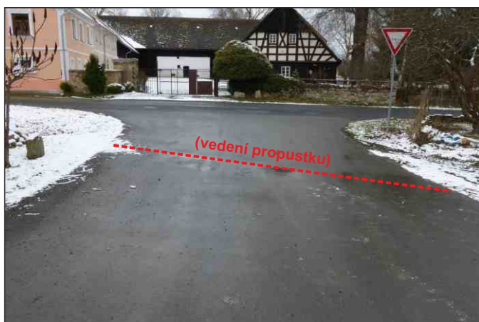
Propustek 10c - staničení 0,119 - celkový pohled
