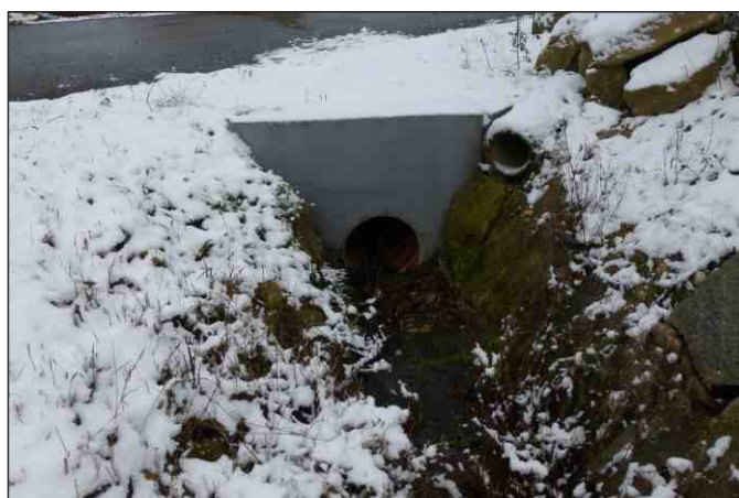
Propustek 10c - staničení 0,119 - pohled zleva
