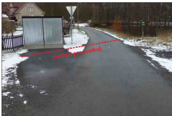
Propustek 7c - staničení 0,014 - celkový pohled
